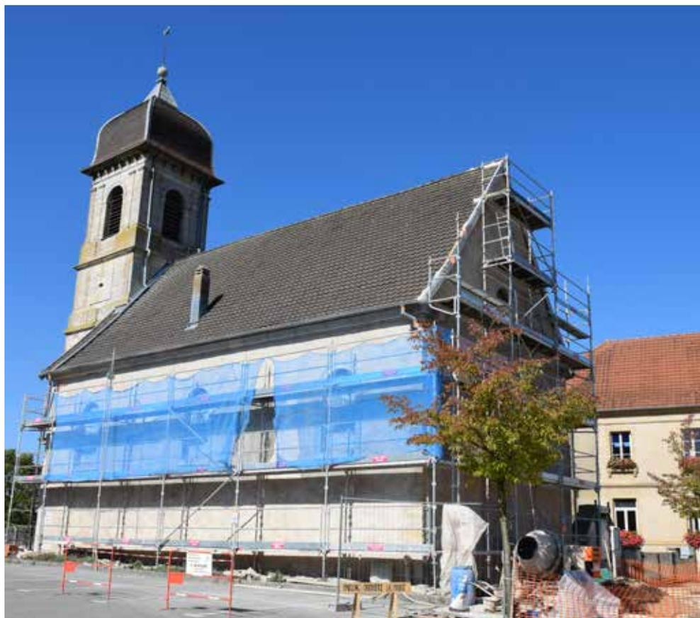
Endommagé par une importante fissure qui constituait un risque majeur pour l'ensemble de sa structure, le temple avait grand besoin de travaux pour le préserver. Par ailleurs, une clef de voute formant le linteau d'une fenêtre était en fort mauvais état et nécessitait elle aussi la plus grande attention. La Commune d'Echenans et l'Association de France ont pris la mesure du problème et ont décidé après plusieurs réunions de travail de la réfection du temple
