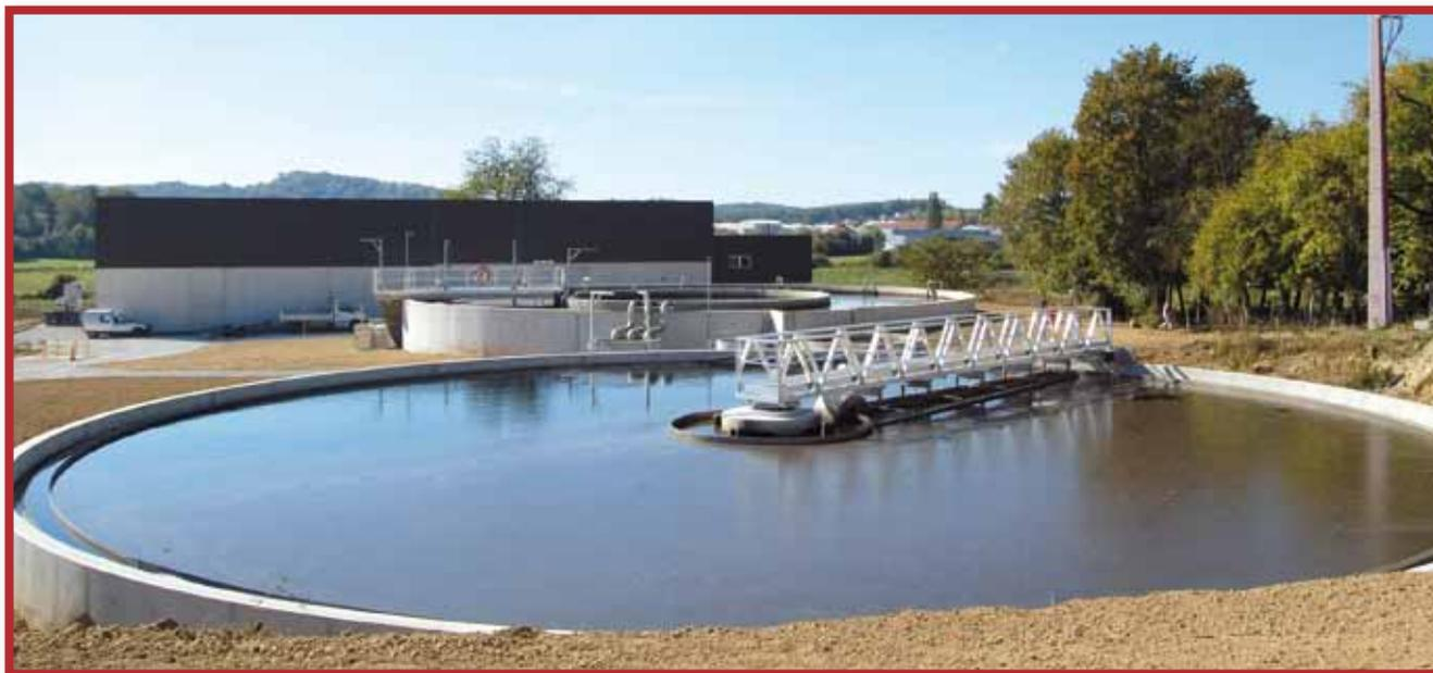
d'une zone anoxie pour traiter les nitrates et d'une zone aérée par insufflation d'air pour traiter la matière organique et l'ammoniac,
